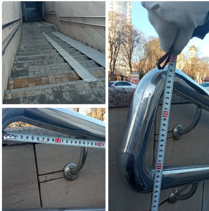
Рис. 1. Измерения поручней на лестнице подземного перехода, который встречается на пути следования туристов.
